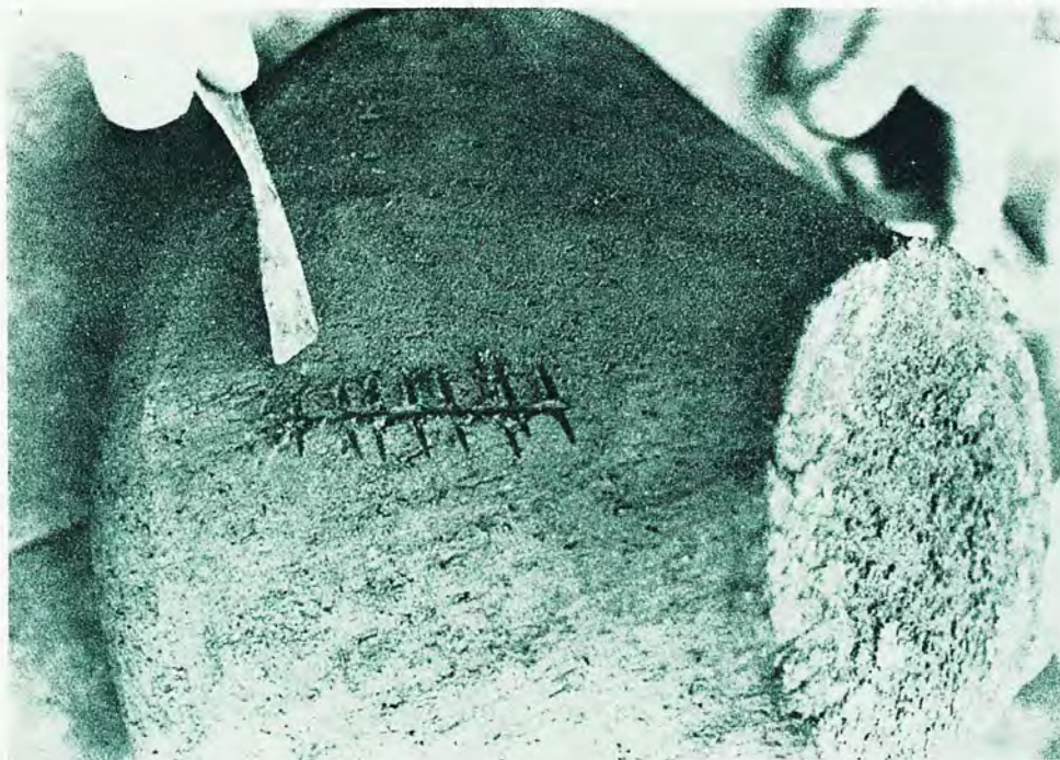
Arreglando una grieta: Cortando con el cuchillo.
