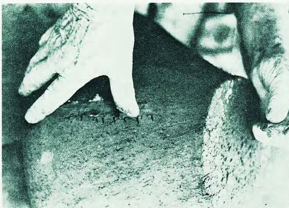
Arreglando una grieta: Tapando con barro.
