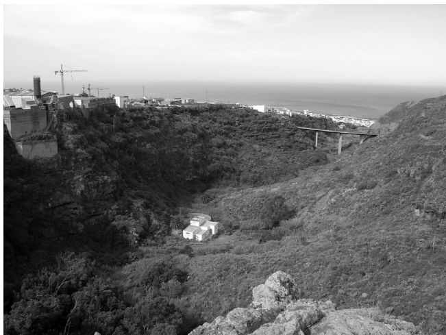
Lám. VI. Tramo final del PE con ubicación del Pozo Bco. del Agua de Dios
